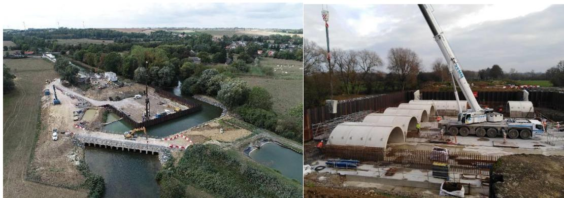
**En 2021,** il est prévu de poursuivre les opérations de dragage (38 000 m<sup>3</sup> de sédiments à extraire), de remplacer les portes de six écluses et de remettre à niveau les équipements électriques, hydrauliques et les automatismes de plusieurs écluses entre Hannapes et Origny-Sainte-Benoîte. Les travaux sur les deux ponts-canaux se poursuivront pour une mise en service en juin 2021, avec des travaux de finition
